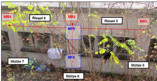
Bild 13 Anordnung der Messflächen MF4 und MF5 sowie der Messbahnen MB3 bis MB5 Außenseite
